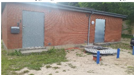
Vandværksbygning med slamtank udenfor bygningen
