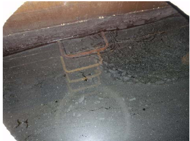
Rentvandstank - kalkudfældninger
