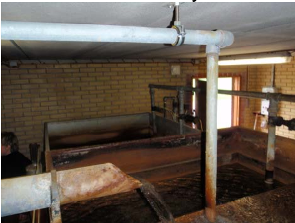
Filtre og tilgang fra reaktionsbassin
